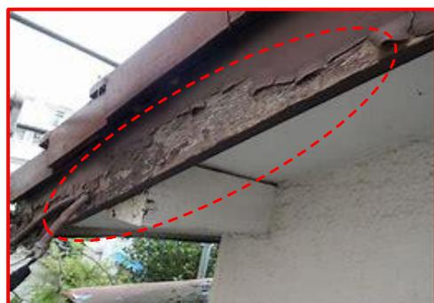
塗膜の寿命が切れ塗膜の剥がれが
