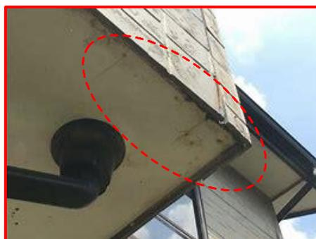
紫外線によるベランダ床の塗膜低下
