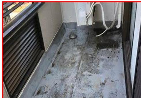
紫外線によるベランダ床の塗膜低下
